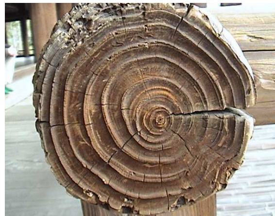
2. ábra – A szabadban lévő bütüfelület erodálódása (Japán ciprus)
