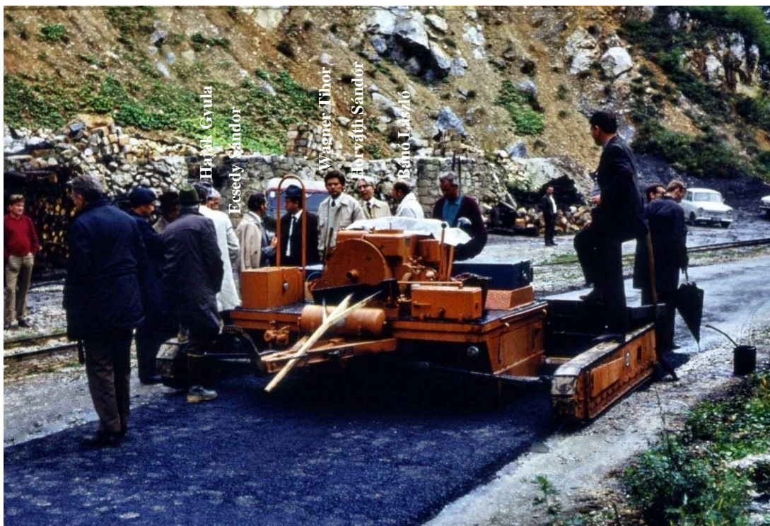
Meleg aszfalt beépítése az Egri Erdőgazdaságnál (1)
