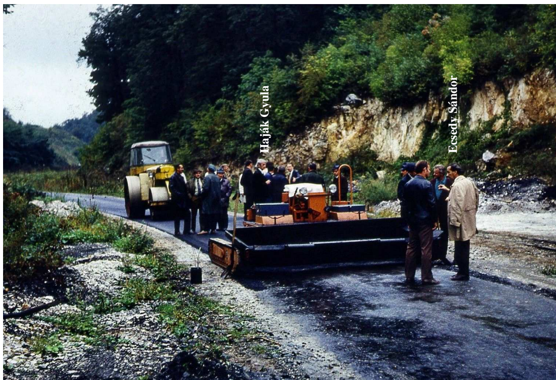
Meleg aszfalt beépítése az Egri Erdőgazdaságnál (2)
