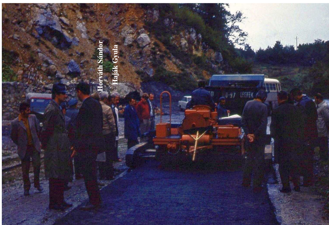
Meleg aszfalt beépítése az Egri Erdőgazdaságnál (3)
